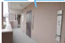
GNS アンカー工法
