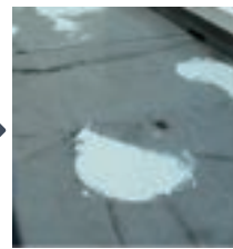
防水剤にて補修
