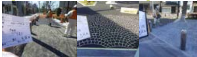
〈07〉 塗装2回目 〈08〉 型紙剥がし 〈09〉 施工後
