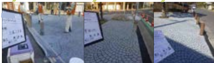
〈07〉 塗装2回目 〈08〉 型紙剥がし 〈09〉 施工後
