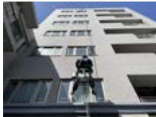
写真は、マンション9階のガラス廻りのシーリングの更新工事をしている様子です。こちらの物件は、窓廻りから漏水してしまっている状態でした。早めに補修しないと、大きな被害になる可能性があったのでチェア型ゴンドラにて施工を行いました。
