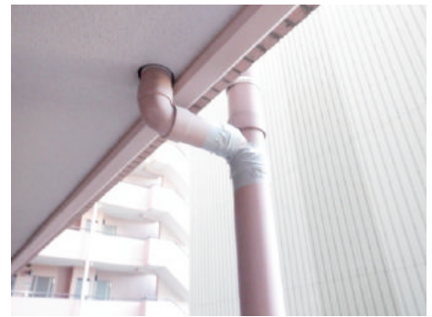
防水テープを巻いて 応急処置の完了です
