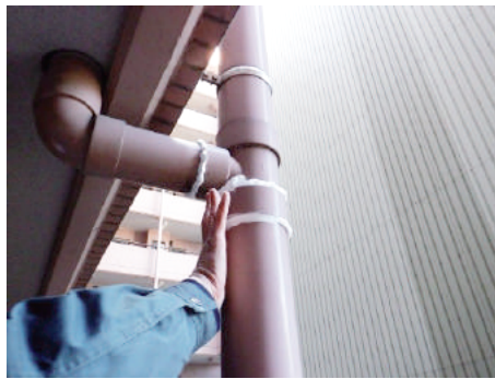
水が漏れている箇所に シーリングを施します
