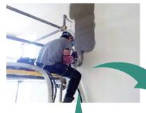
カップの内側で、 高圧水の噴射と廃材の吸引が 同時に行われます。
