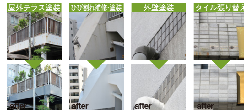
外壁は洗浄や塗装、タイルの張り替えで美しく蘇らせた。劣化が進んだ西側斜面はひび割れにくい柔軟下地材で躯体を補修してから塗装し、耐久性を高めた。
