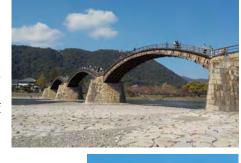
5連のアーチからなるこの橋は、全長193.3m 幅員5m、主要構造部は継手や仕口といった組木の技術によって、釘は一本も使わずに造られています。橋体に使われている木材は、マツ、ヒノキ、ケヤキ、クリ、カシ、ヒバで木材の特性により使い分けられています。
